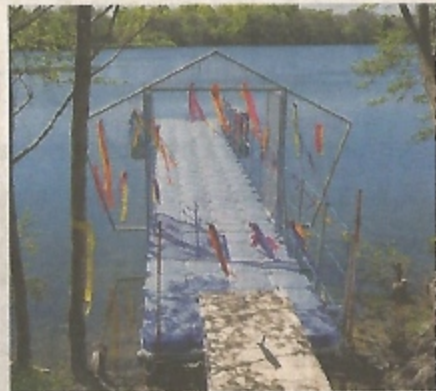
Die neue Steganlage ist durch ein Tor gesichert. Fotos: Vortanz
